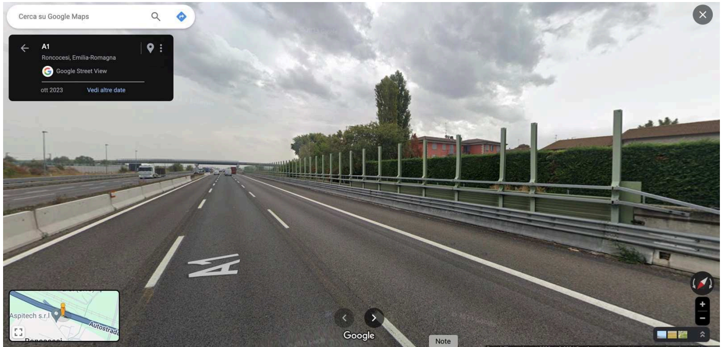
Figura 1 - Stato barriere antirumore ottobre 2023
